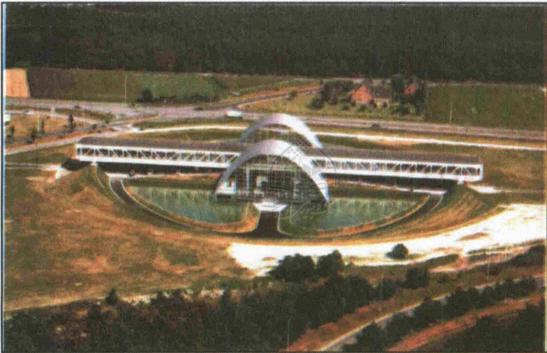
شكل (٢١): مبنى مركز أبحاث تطوير الفولاذ ببلجيكا، ويتضح استخدام هيكل حديدية على شكل قوس دائري للحصول على مساحات كبيرة جدا دون الحاجة إلى أعمدة إلا على أطراف هذه الفراغات (١) .
