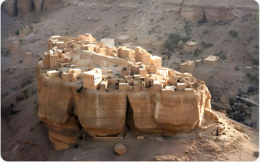
شكل (١٤): نموذج لتأسيس المباني على أرض صخرية طبيعية صلبة.
